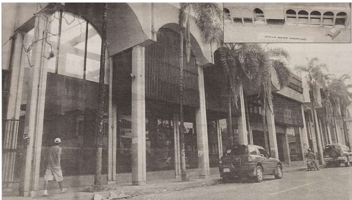
Edificio Ex - Banco Boliviano Americano, Calle Rene Moreno N°369, Foto: El nuevo día. (El Nuevo Día, 2008)
